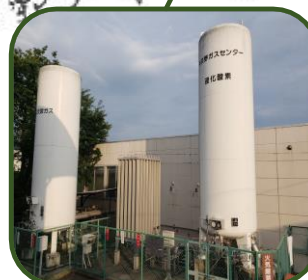
充填工場：大阪府交野市
