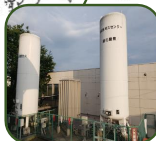
充填工場：大阪府交野市
